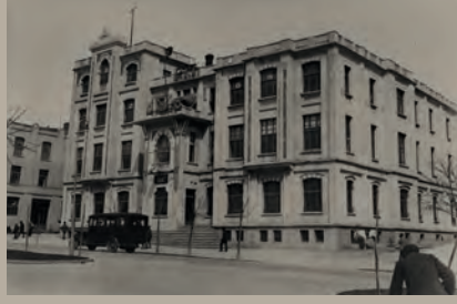
Ulus Postane Binası
